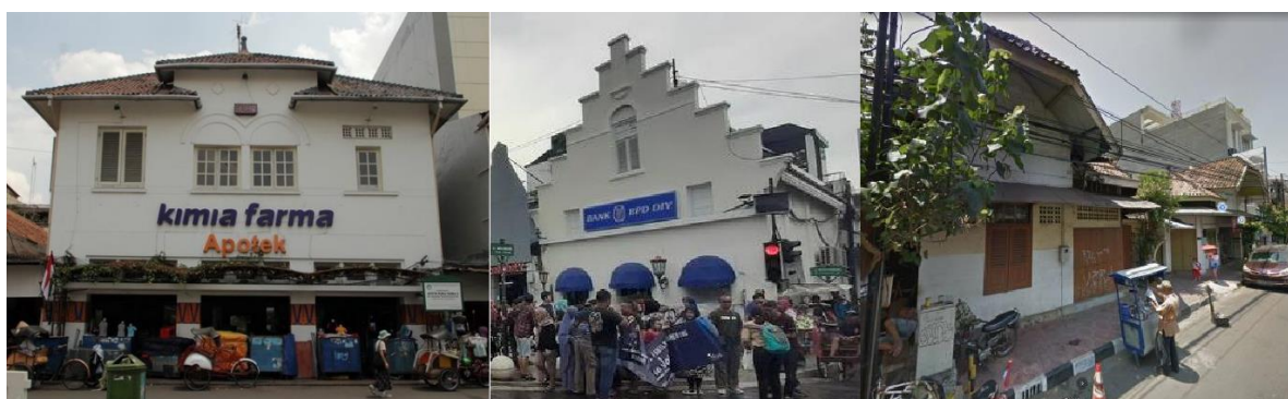
Gambar 26 Bangunan eksisting berlanggam Indis di Kawasan Malioboro.
